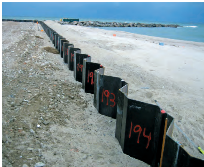
Figur 1. I 2006 blev et areal på 20.000 m 2 indkapslet med en stålspuns til 14 meters dybde for at forhindre udsivning til havet. Depotet blev tildækket af en topmembran af plast for at forhindre nedsivning af regnvand.
