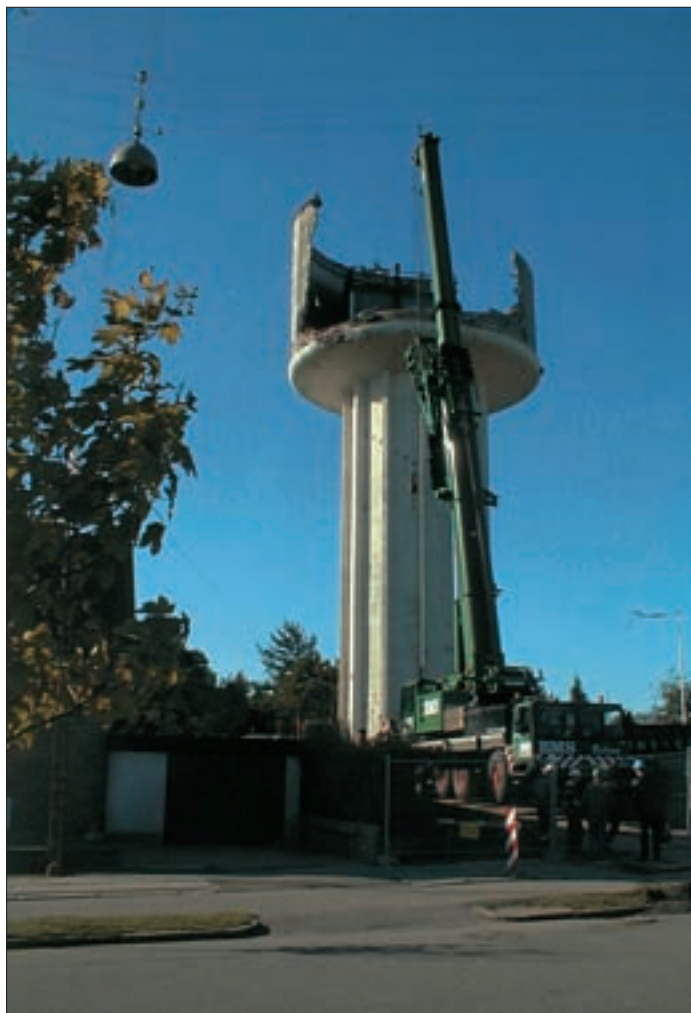
Ældre vandtårn under nedrivning. Tårnet var under mistanke for at være kilden til den store vandforurening i Århus i 2002. Der var mindre revner og huller i taget, hvor vand med fugleklatte kunne sive ind. Foto: Århus Kommunale Værker.
